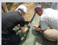
除草・防草シート設置
